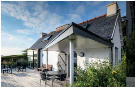
Rénovation - CALC architectes, Ploue-
