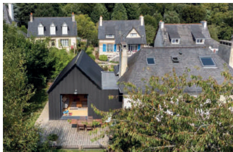
Extension - CALC architectes, Morlaix
