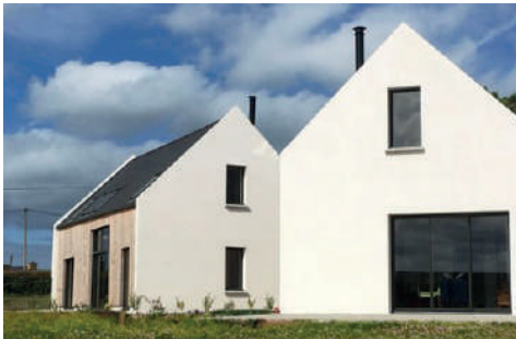
Rénovation-GA, Plouneour Trez
