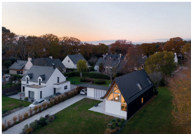
Maison Poge - Node architectes
