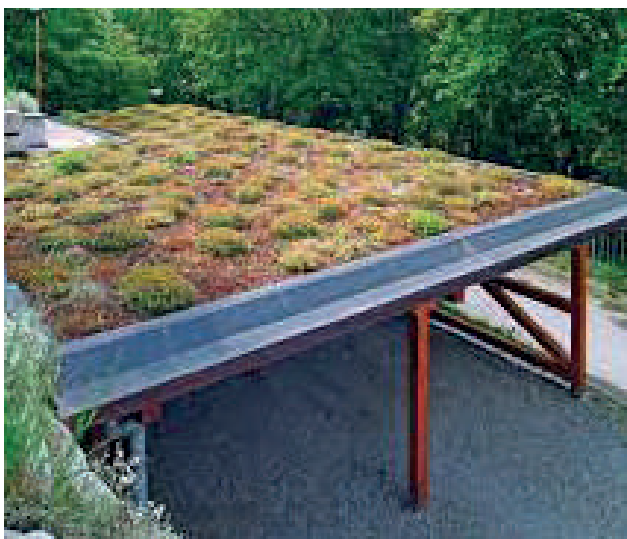
Carport avec toiture végétalisée
