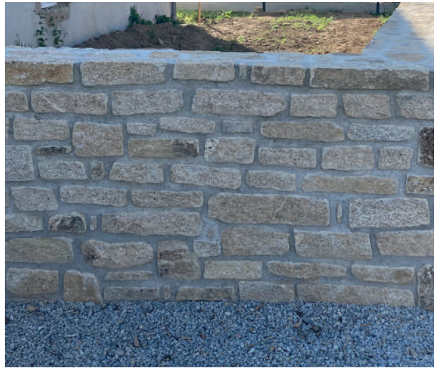
Muret en pierre
