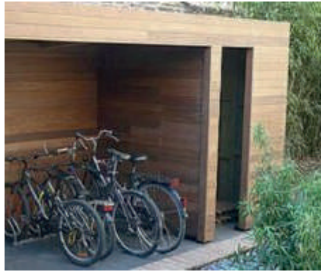
Local annexe pour les vélos
