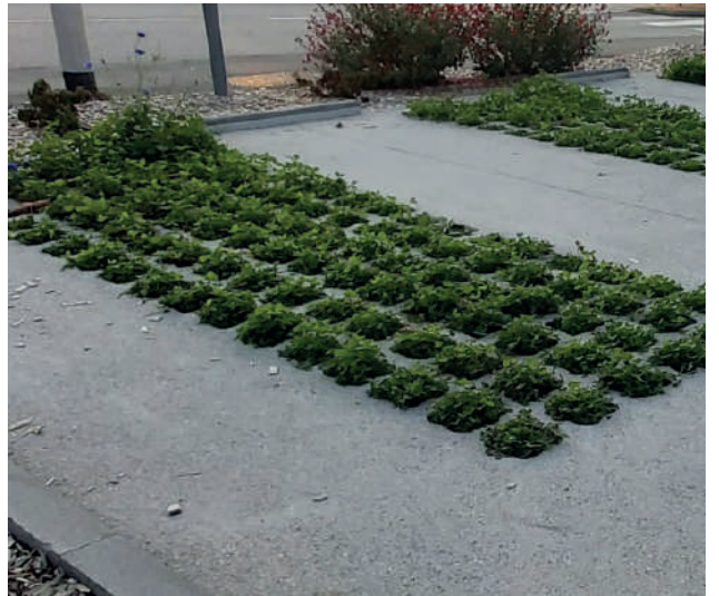
Imperméabilisation uniquement des bandes de roulement
