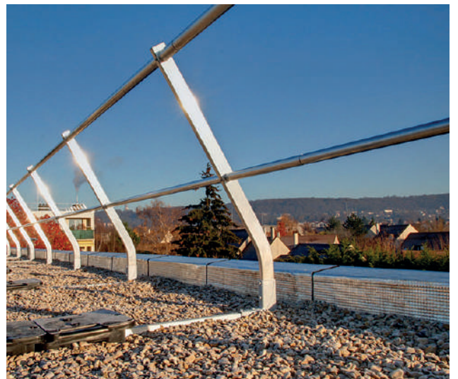
Barrière toiture-terrasse sur du collectif
