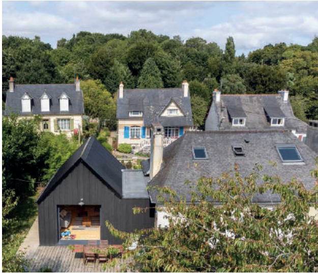
Extension - CALC architectes, Morlaix
