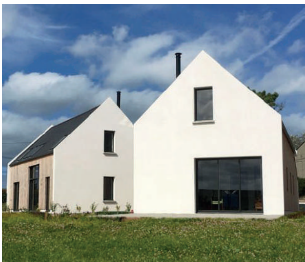
Rénovation-GAA, Plouneour Trez
