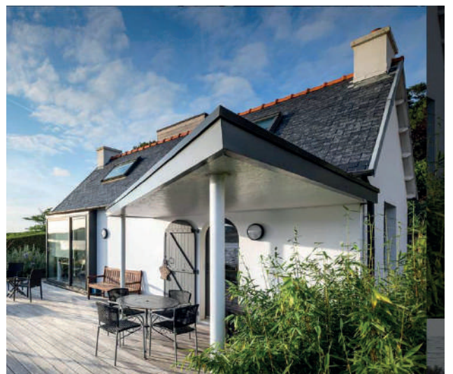
Rénovation - CALC architectes, Plouezoc'h
