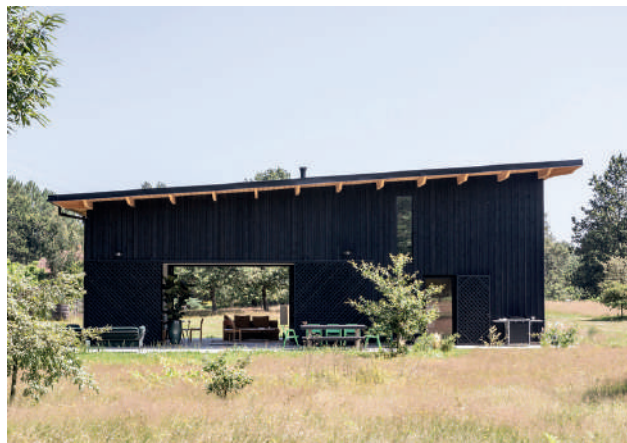
Maison AER - Lesgourgues
