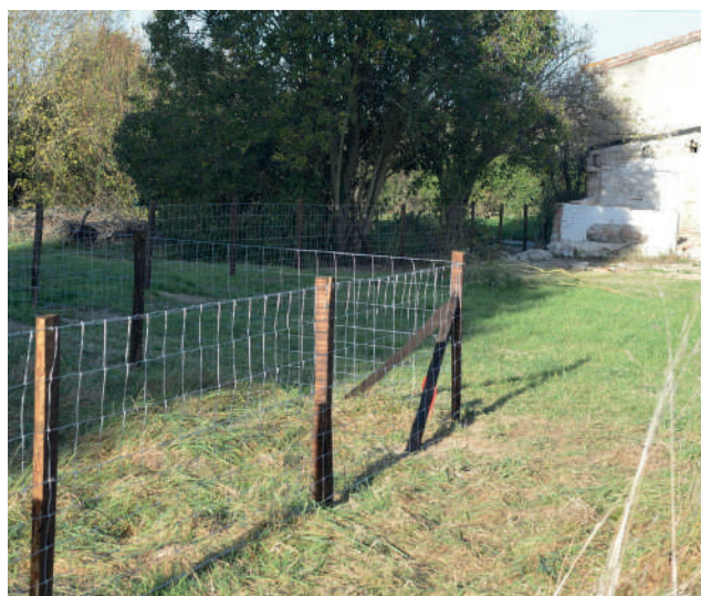
Clôture en simple grillage
