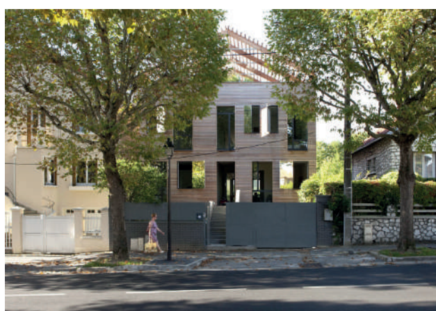
Maison intergénérationnelle - TICA architecture
