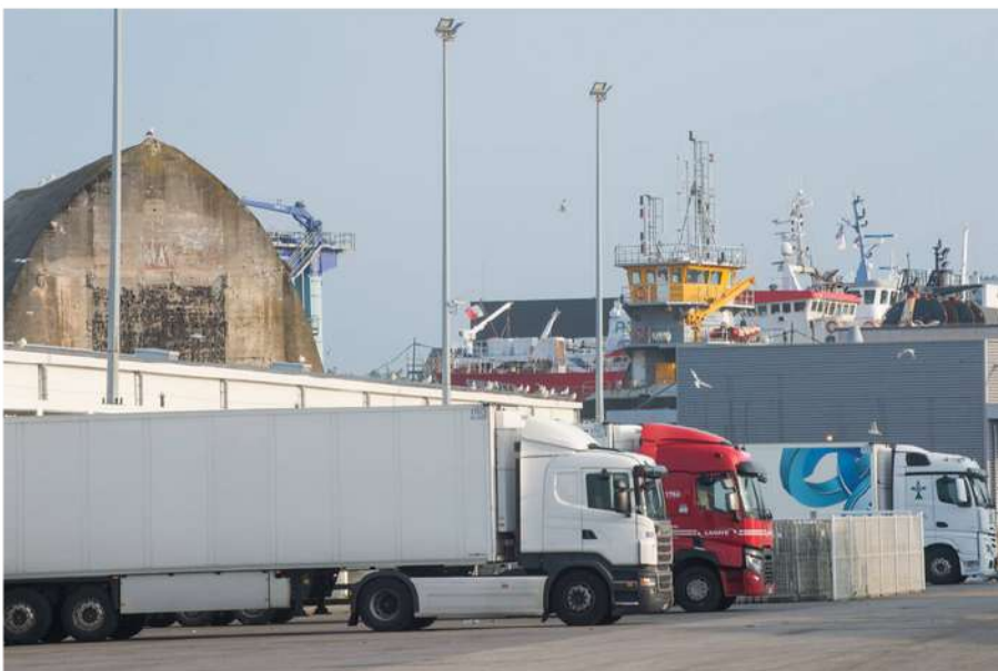
La Gare à marée - Crédit photo Lorient Agglomération - Cohonner Hervé
