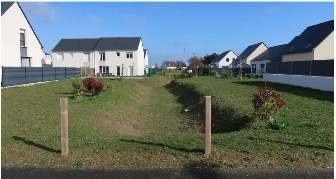
Exemple de noue destinée à retenir et à infiltrer les eaux pluviales.
