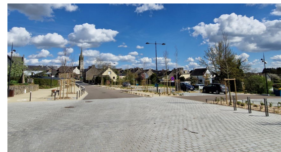
Du pavé granit pour les placettes et une bordure granit large pour séparer l'espace véhicules et piétons
