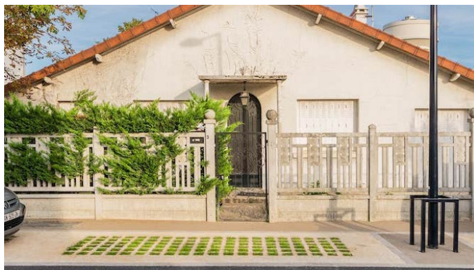
Impact positif sur la gestion des eaux pluviales, pas de nécessité de bordurage
