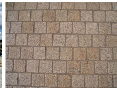
Du pavé granit pour les placettes et une bordure granit large pour séparer l'espace véhicules et piétons
