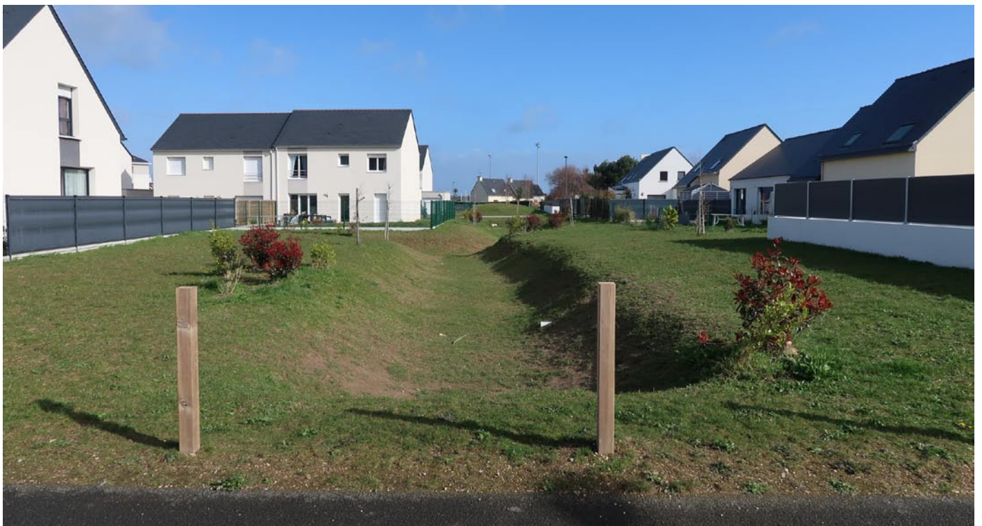
Exemple de noue destinée à retenir et à infiltrer les eaux pluviales.
