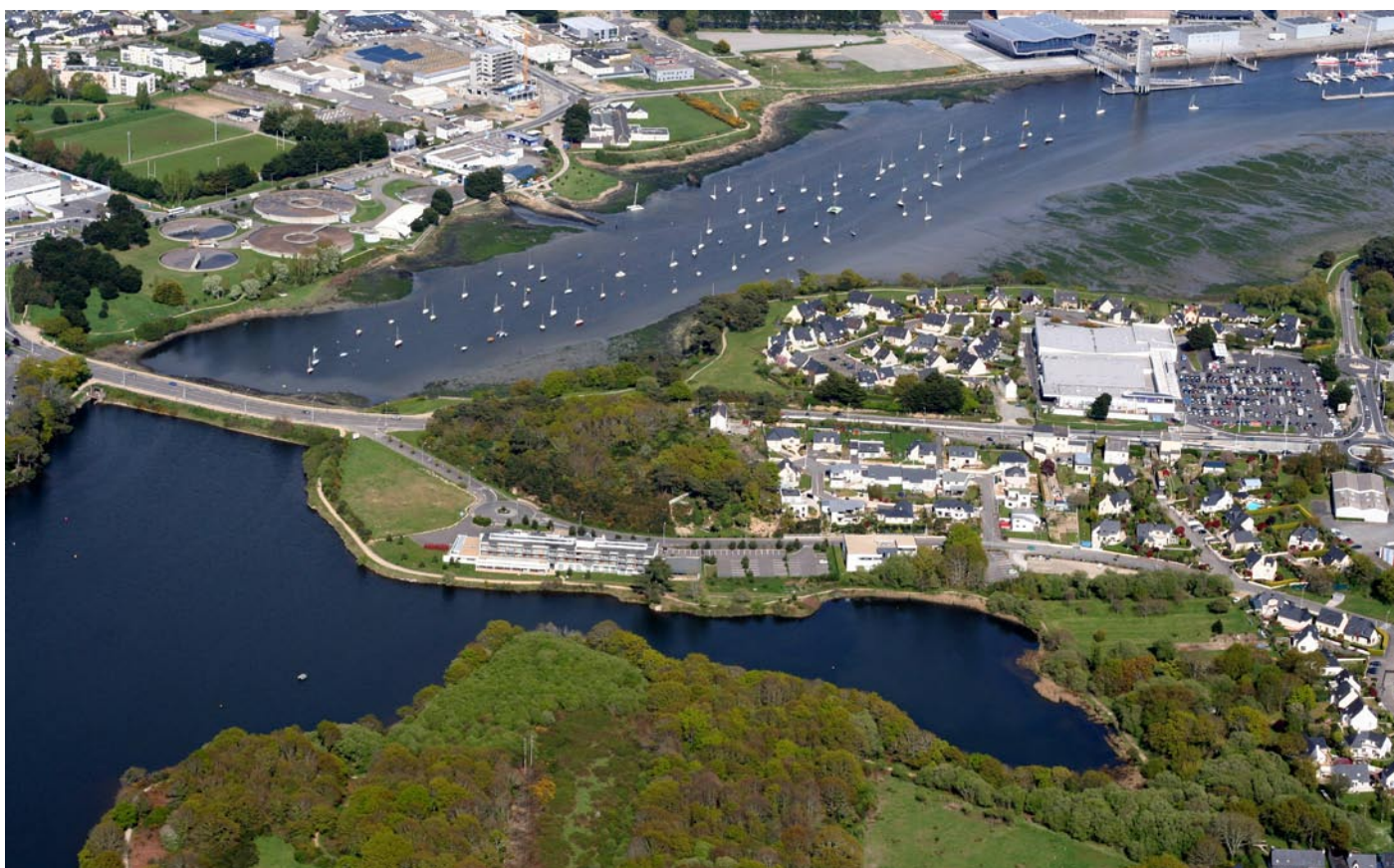
En haut à gauche, la station d'épuration de Lorient - Kerolay, qui traite les eaux usées de Larmor-Plage.
