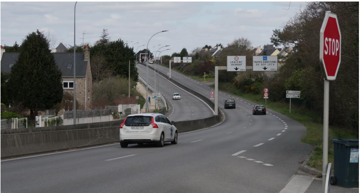
La D 29, de même que la D 152 qui la prolonge le long du littoral, est classée voie bruyante.
