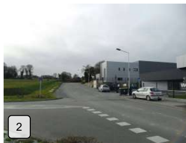
Boulevard Antoine Lavoisier, des constructions aux formes industrielles caractéristiques
