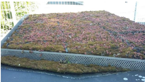
Figure 23: Toiture végétalisée – Région de Douai (62)
