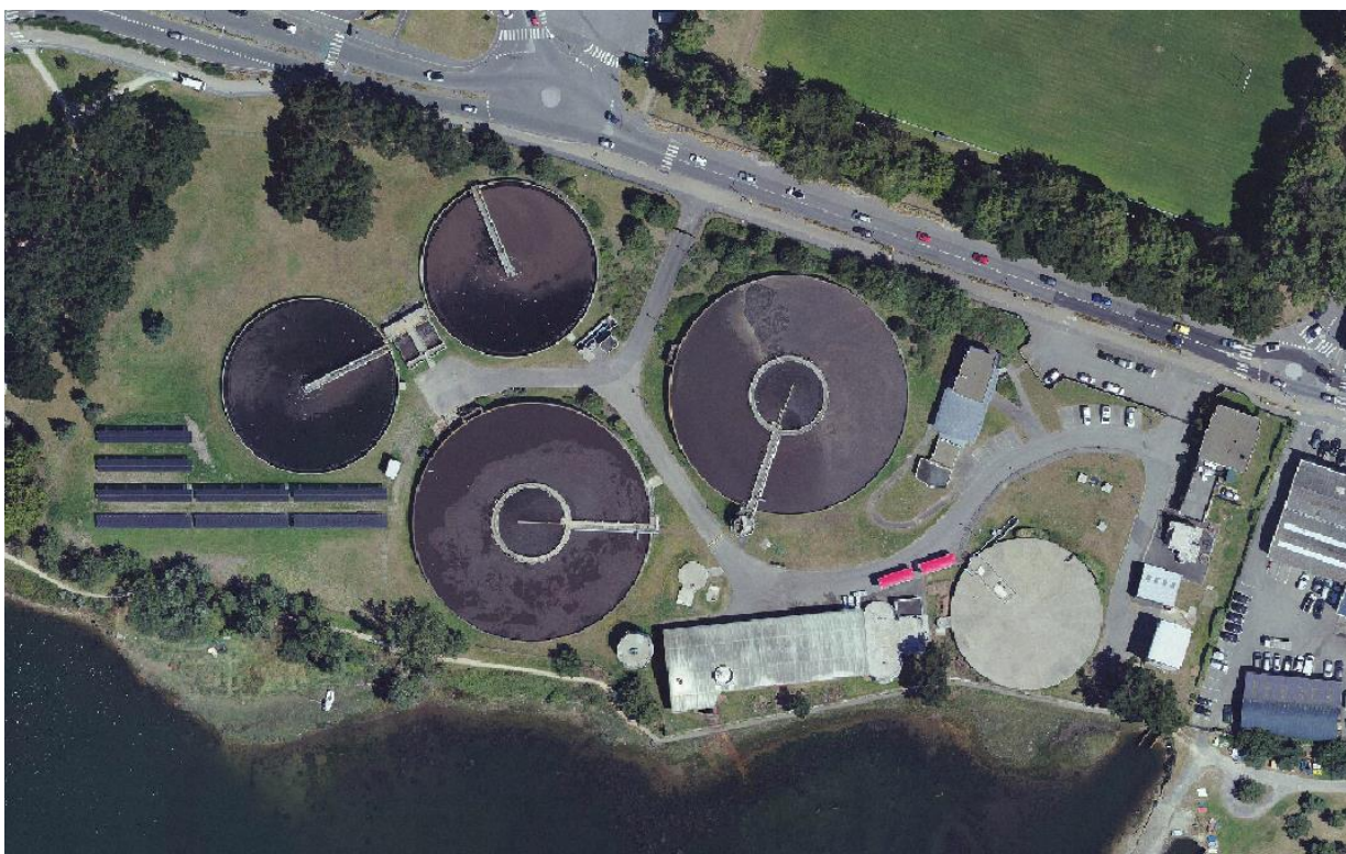
Figure 41 : station d'épuration de Lorient Source : Orthophoto - 2019
