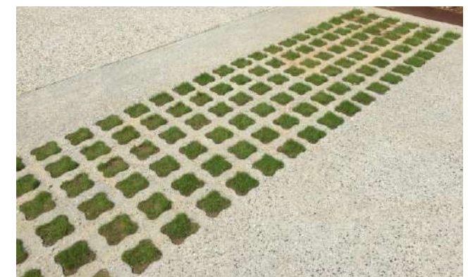
Pavés ou béton joint gazon > Stationnement
