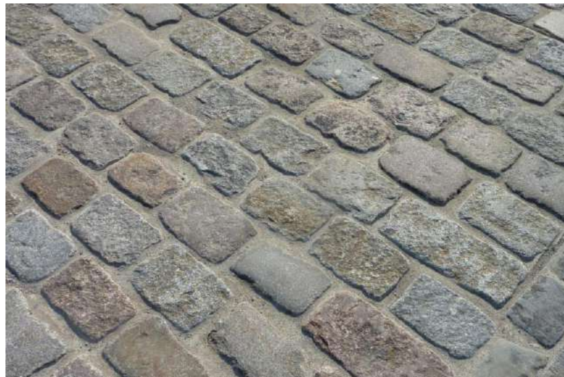
Pavés granit > Voirie et trottoirs aux abords de la Fontaine de Keramzec
