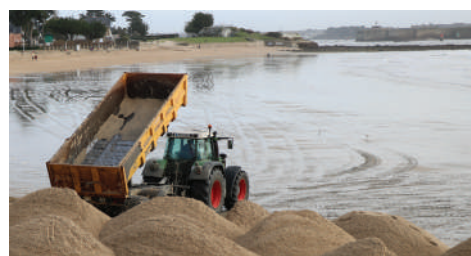
Travaux à la mer : 100 000 €
